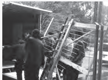
解体した音響彫刻の搬出
