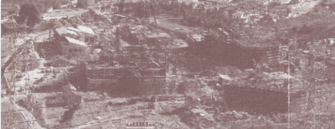
建設中の首掛キャンパス、1979(昭和54)年
