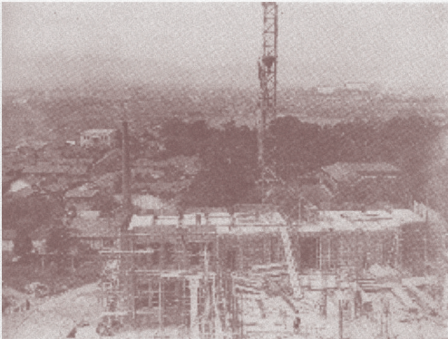
建設中の今熊野校舎、1926(大正15)年
