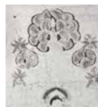
模造壁に墨線を転写する
