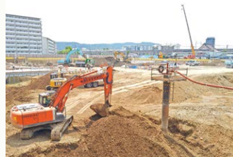
C地区での工事の様子
