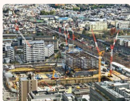
工事現場の様子(京都タワーから)
