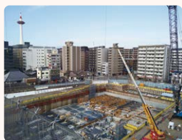
建設中建物の最上階から
