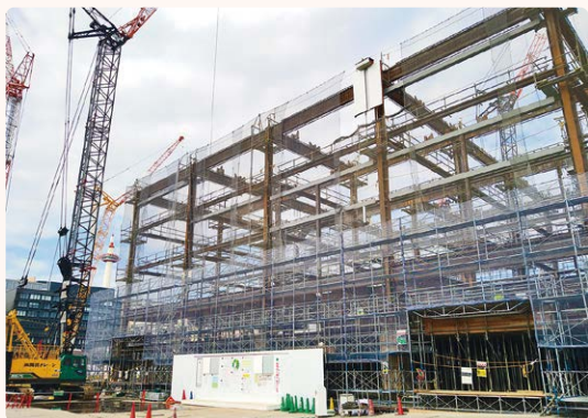
建設中の建物
