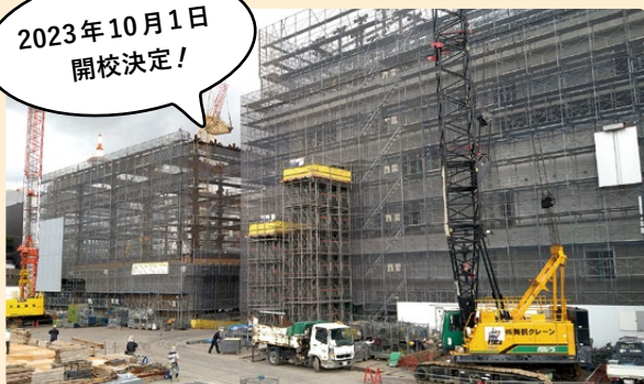
建設中の建物
